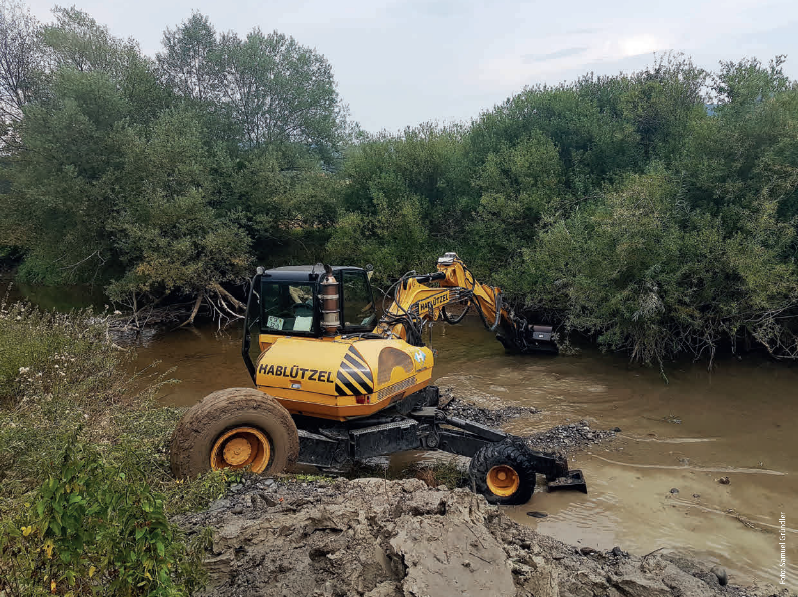
▲ Abbildung 4: Ausbaggerung eines Rheinzufusses zur Schaffung von tiefen Kaltwasserzonen
